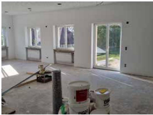
Der Gemeinderaum in der Renovierung | Fotos: Peter Hohlweg
